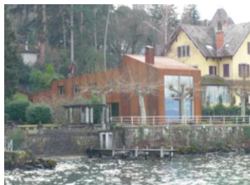
Casa 26 - façade acier corten
